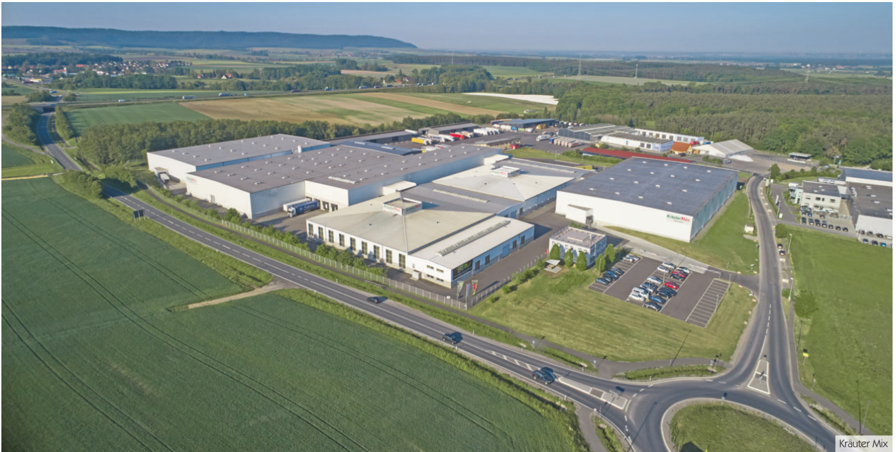
In Wiesentheid, direkt an der Autobahn zwischen Nürnberg und Würzburg, liegt das Logistikzentrum von Kräuter Mix.
